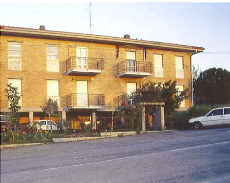
Intervento in via Brocchi
