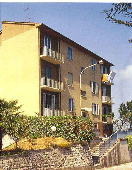
Intervento lungo la via XXV Luglio
