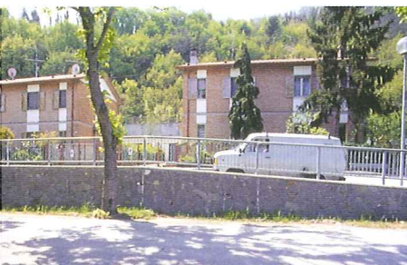
Intervento lungo la via XX Settembre nella frazione di Montefiore Conca
