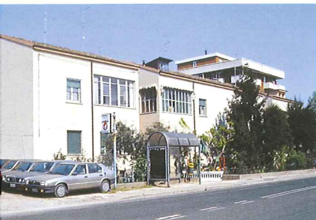
Misano: Intervento lungo la S.S. Flaminia
