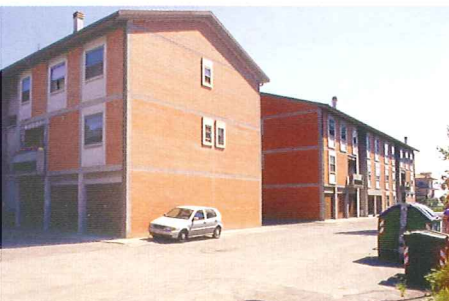
Vista complesso edilizio di Santa Giustina
