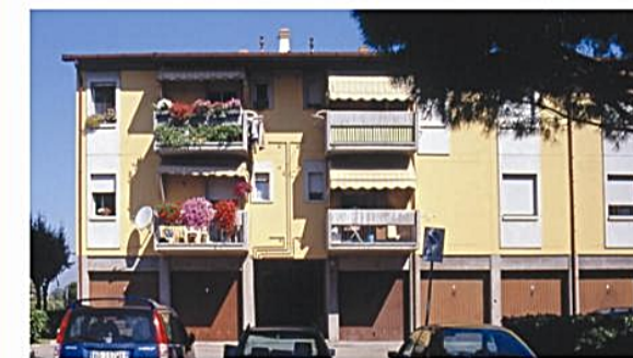
VISTA LATO OVEST
