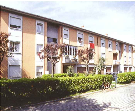
Veduta del retro di un fabbricato IACP nel quartiere "Spadarolo" di Rimini
