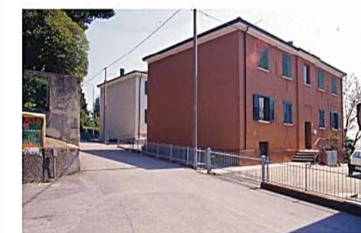
MONDAINO - VIA MONTEBELLO
