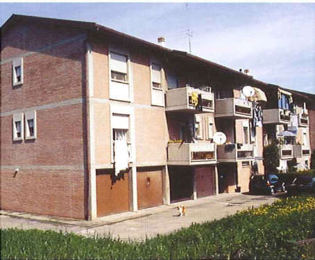
Vista retro edificio di 24 alloggi
