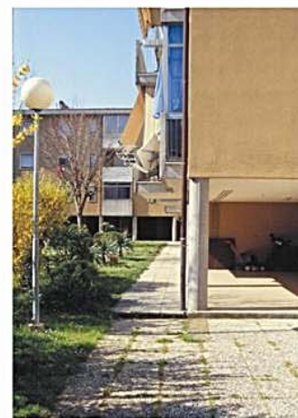
EDIFICIO -C- PORTICO
