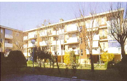
Veduta dalla corte interna edifici C/2 e C/3
