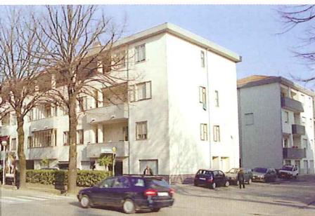
Veduta da via della Fiera edificio progettato nel 1972 dall'Ing. Dionigio Costa
