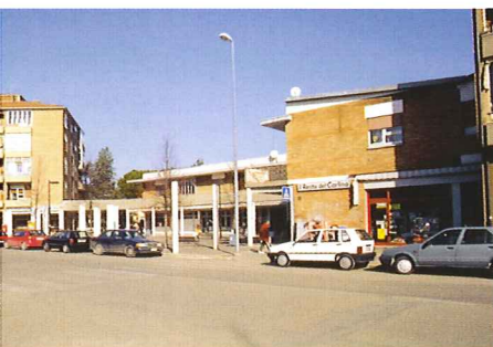
Veduta generale piazzetta; a sin. l'edificio a torre, al centro il blocco con servizi a 2 piani
