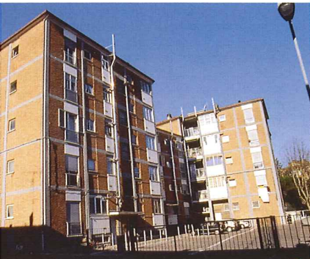
Veduta edificio tipo "B" situato in via Coletti
