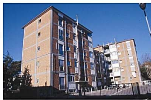
EDIFICIO TIPO -A-
