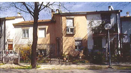
Vista fronti principali casette a schiera affacciati sulla strada
