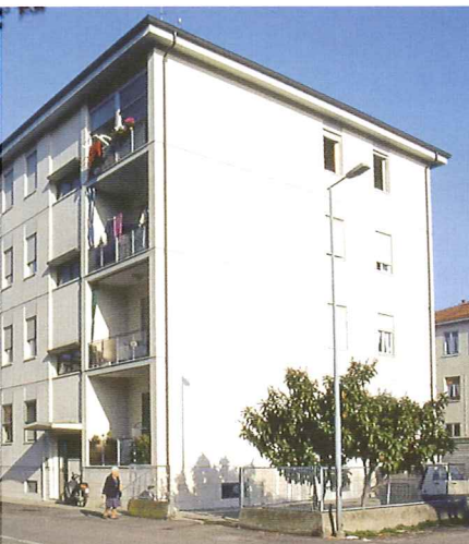
Veduta laterale sulla via Giuliano edificio a "L", 1961.
