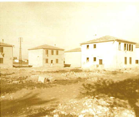
Foto intervento zona S. Spirito, 1948
