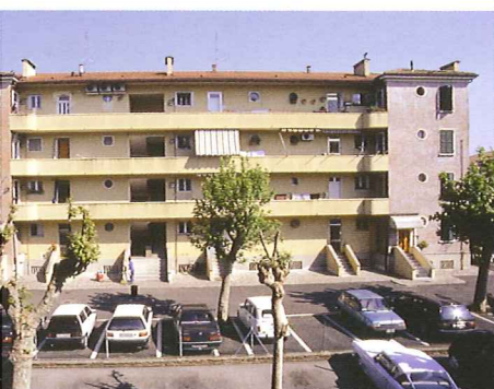
Prospetto fronte principale edificio com-pletato nel 1941. In evidenza gli ingressi indipendenti al piano terra e i ballatoi esterni di distribuzione agli alloggi ai piani superiori
