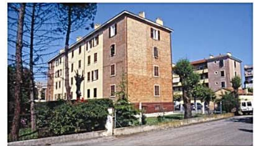
EDIFICIO 1949 - VISTA ESTERNA
