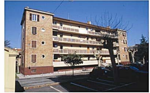
EDIFICIO 1949 - VISTA INTERNA
