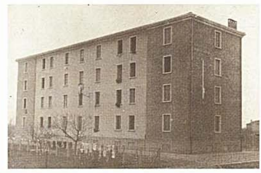
EDIFICIO 1940 - VISTA ESTERNA
