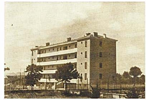
EDIFICIO 1940 - VISTA INTERNA
