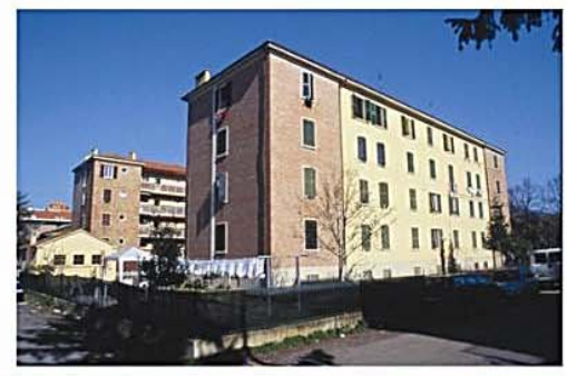
EDIFICIO 1940 - VISTA ESTERNA
