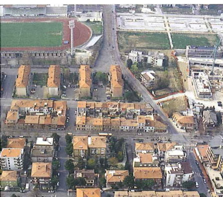
Vista panoramica intervento in via Balilla
