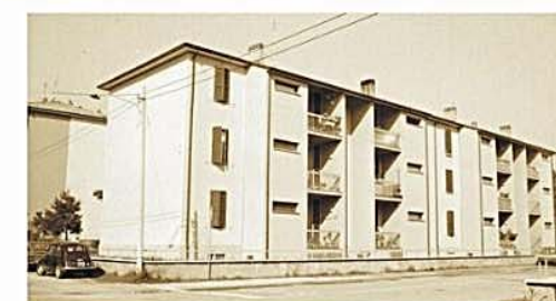
VISTA FINE ANNI '70 DOPO LA RISTRUTTURAZIONE
