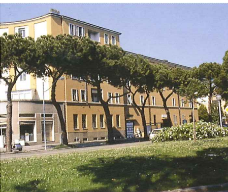
Veduta lungo la via Matteotti (ex XXVIII Ottobre) dell'edificio (A) realizzato nel 1938
