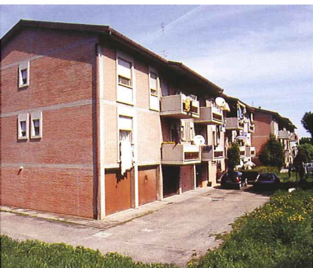
Veduta edifici IACP realizzati primi anni '80 nella frazione di Corpolo, lungo via Gradizza.
