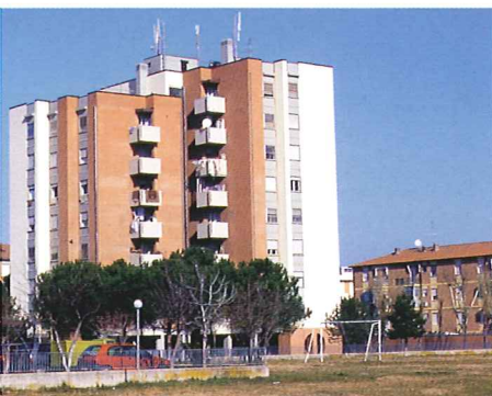
Veduta dell'edificio sito in Via Di Mezzo realizzato nel 1980 dall'Arch. G. Gandolfi (IV PEEP "Marechiese")
