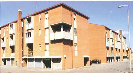
Vista del complesso di via Alessandrini a Rimini, progettato dall'Arch. G. Gandolfi e realizzato dallo IACP di Forlì verso la metà degli anni '70 (V° Comprensorio PEEP).
