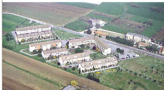
Veduta aerea dell'intervento per l'edilizia economica nella frazione di Orsoletto di Viserba, completato nei primi anni '90.
