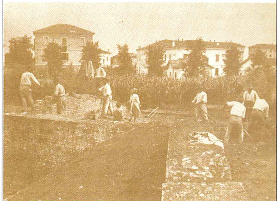
Demolizione delle mura malatestiane nei pressi dell'anfiteatro - 1910
