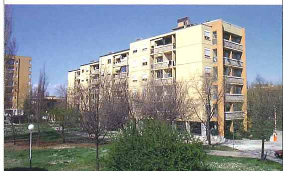
Intervento IACP nel III° Comprensorio PEEP "Celle" di Rimini, anno 1980.
