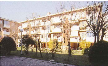
Fabbricato tipo "L" realizzato negli anni '80 dallo IACP di Forlì a Miramare di Rimini (VIII° Comprensorio PEEP).
